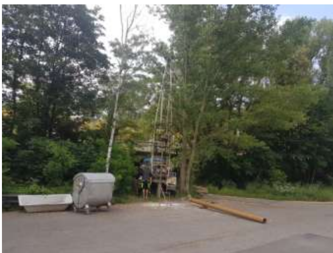
Vrtná souprava při hloubení sondy V1
