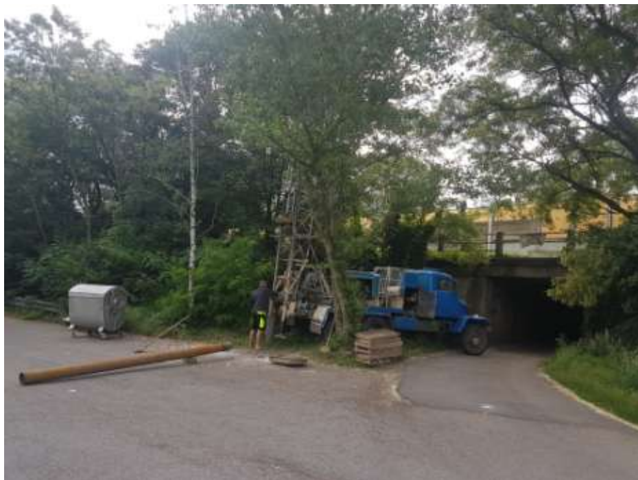
Osazování adjustáž vrtné soupravy pro vrt V1
